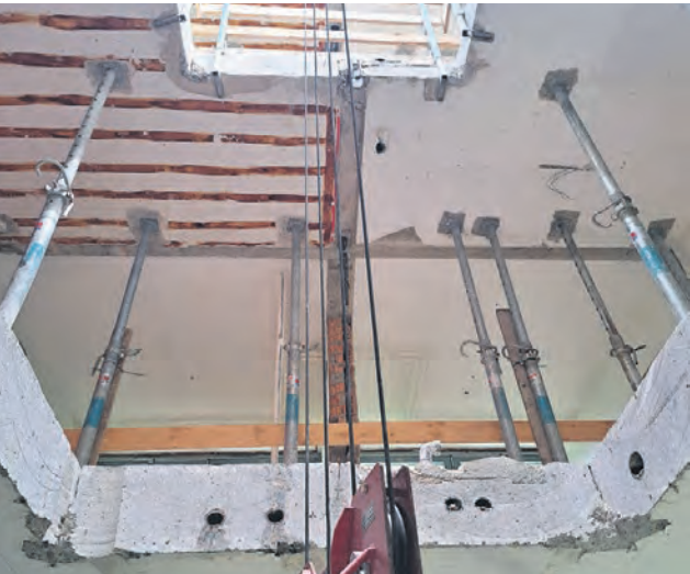
Der Lifteinbau im Klassentrakt dient der Hindernisfreiheit und Erdbebenfestigkeit.
