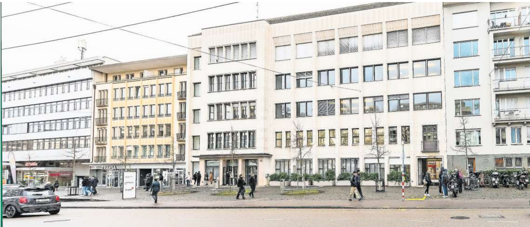
Das Gebäude am Aeschengraben 15 wurde 1937 gebaut, zum letzten Mal renoviert wurde es vor 20 Jahren.
