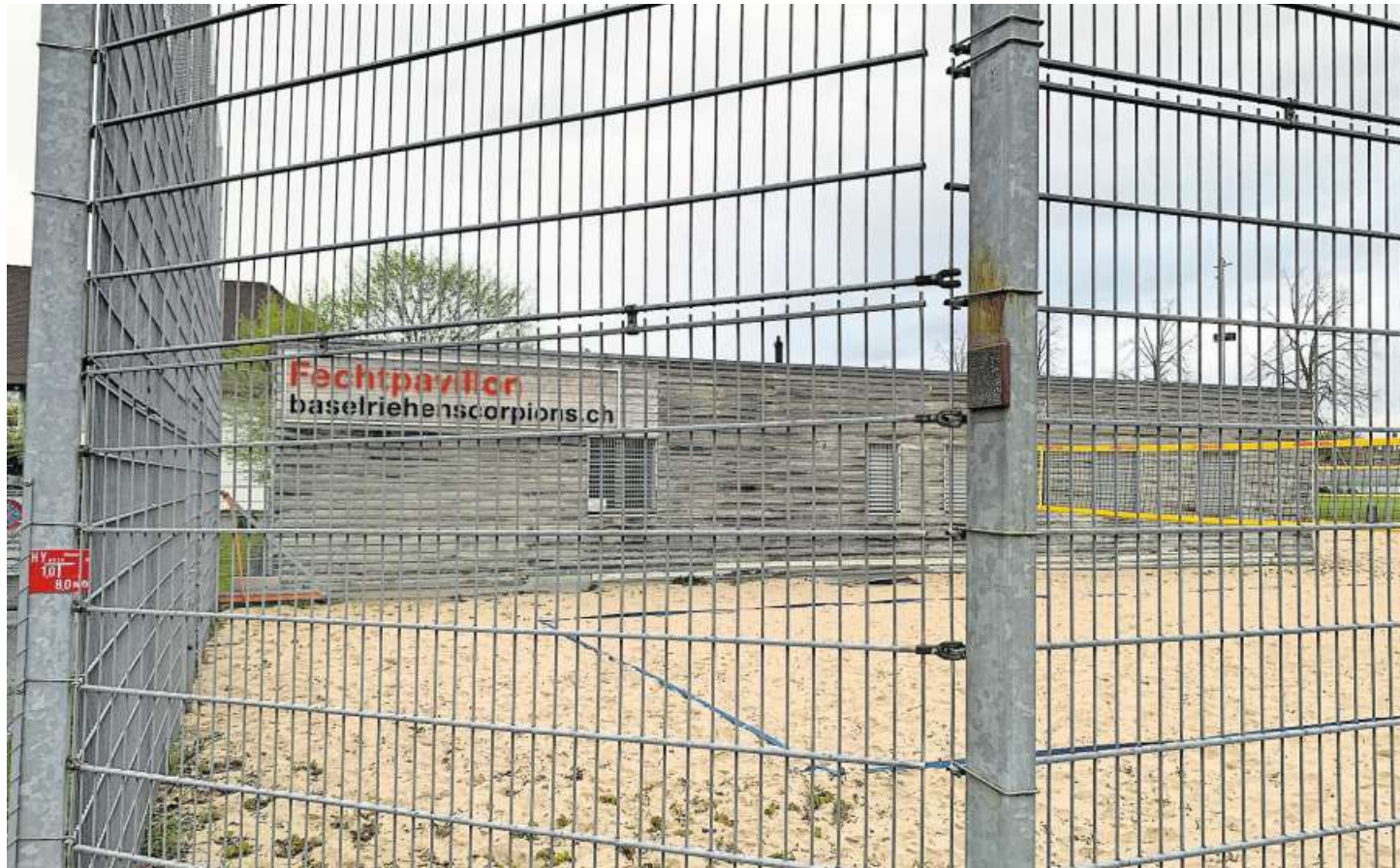
Die Rankhof-Fechthalle wurde Anfang Dezember vom Kanton abgerissen. Der Briefkasten steht noch – und ist randvoll.
