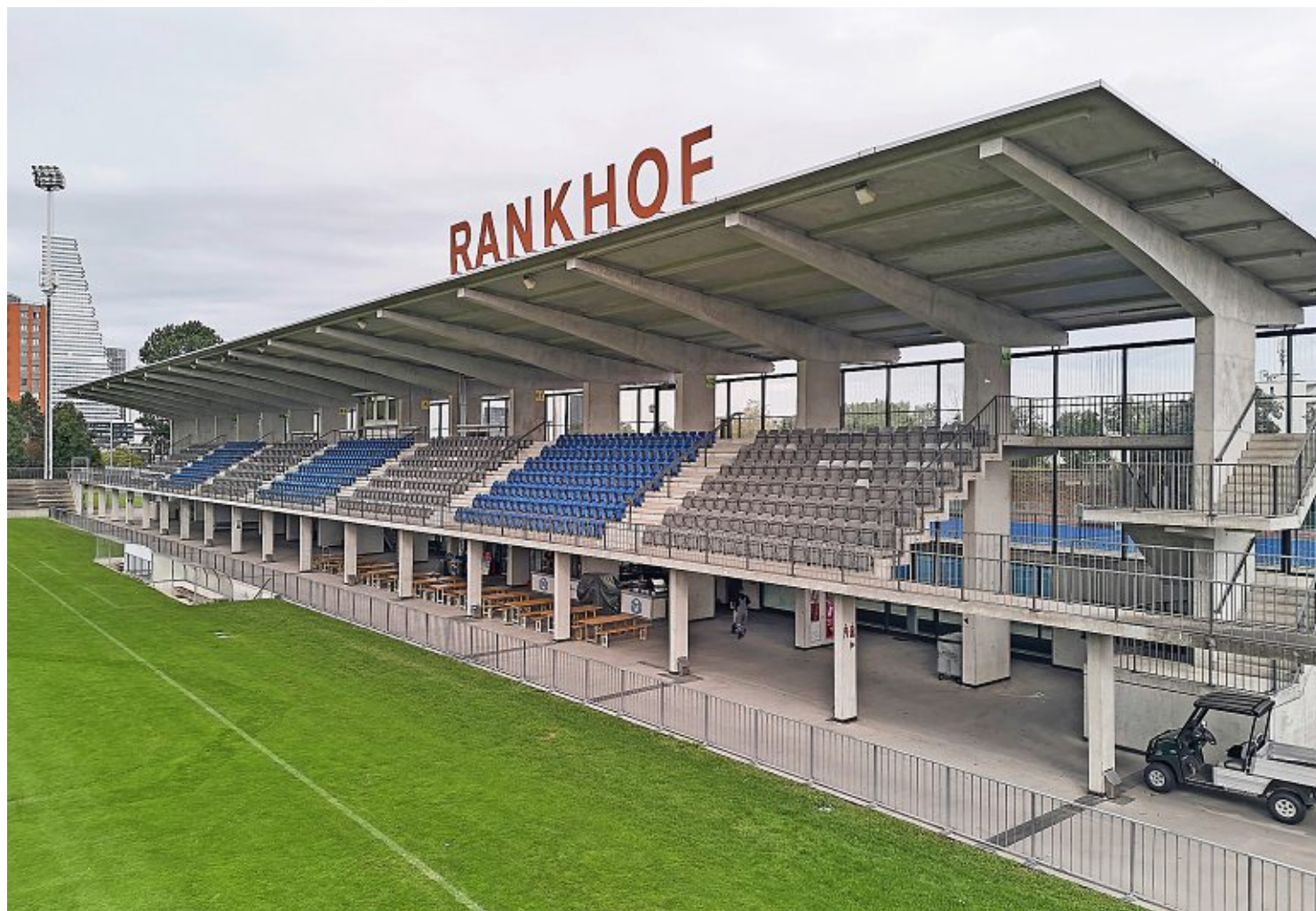
1996 in freiwilliger Arbeit errichtet: Die neue Tribüne aus Beton mit dem Schriftzug «Rankhof». Foto: Lucia Hunziker
