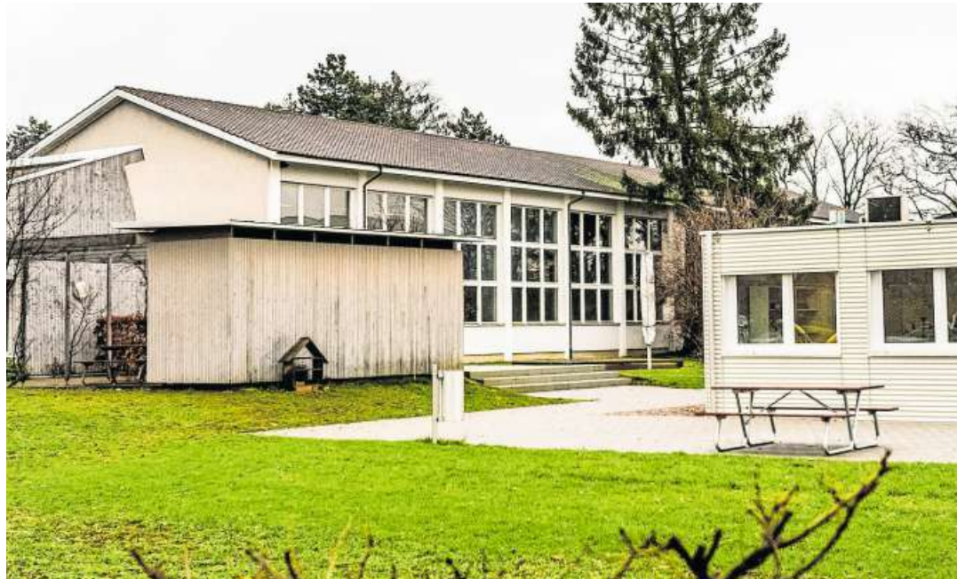
Die Hirzbrunnen-Turnhallen: Der Grosse Rat will sie abreißen und ersetzen, der Regierungsrat will sie sanieren.
