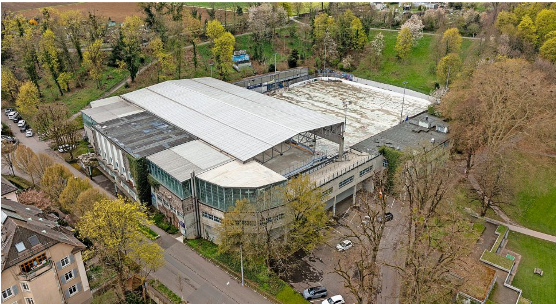
Die Kunsteisbahn Margarethen soll ab den 2030er-Jahren zum sogenannten polysportiven Zentrum werden. Foto: Dominik Plüss
