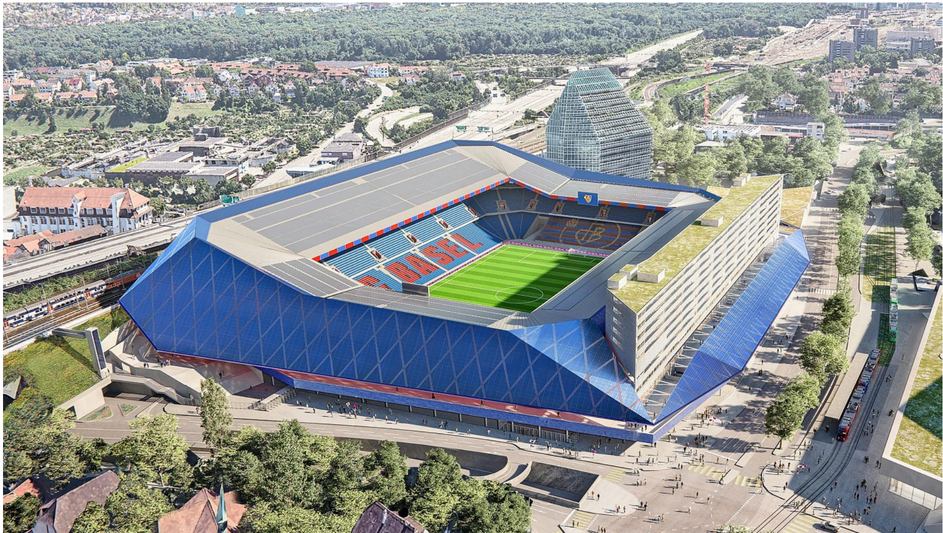
Die neue Hülle, eine riesige Fläche aus Photovoltaik-Modulen. Foto: STADION+
