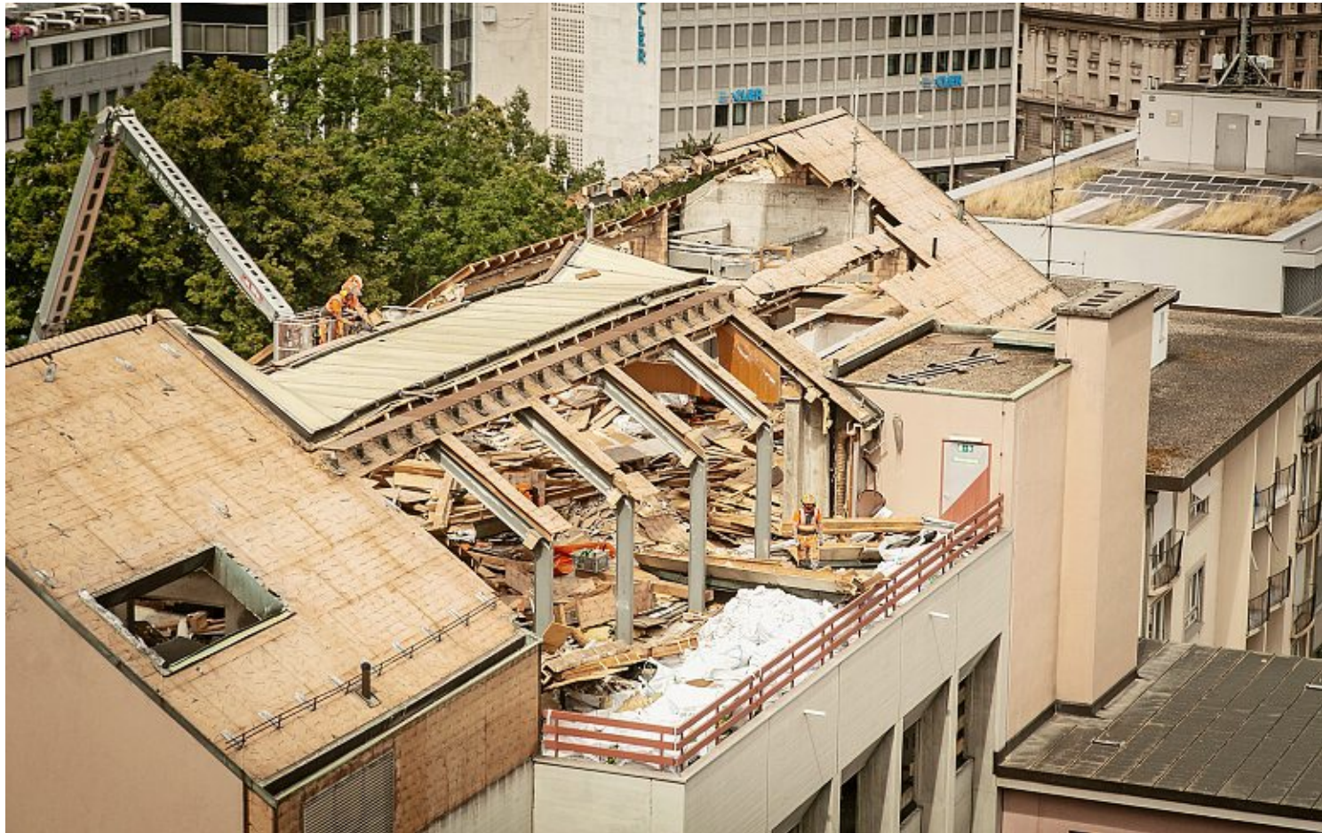
So viel ist vom alten Giebedach noch übrig. Der Rückbau schreitet voran. Foto: Nicole Pont
