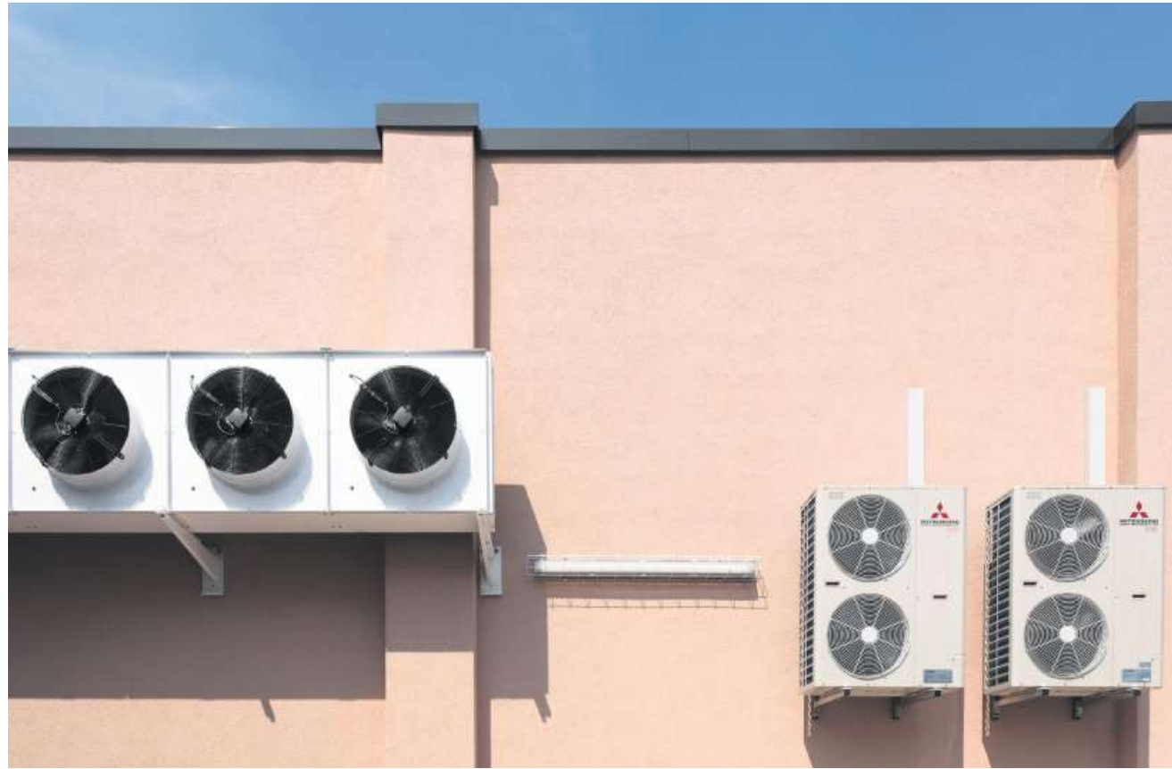
Split-Klimaanlagen bestehen aus zwei Geräten. Eines hängt draussen an der Fassade, eines drin an der Decke.
