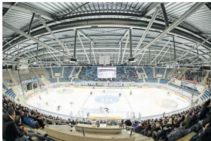
Vor einigen Jahren wurde die Eisbeleuchtung an der Decke durch neue LED-Scheinwerfer ersetzt. Bild: Marc Schumacher
