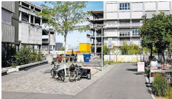
Auf dem Areal Lysbüchel soll eine Passerelle vom Beckenweg zum Schulhaus Lysbüchel entstehen. Bild: Kenneth Nars
