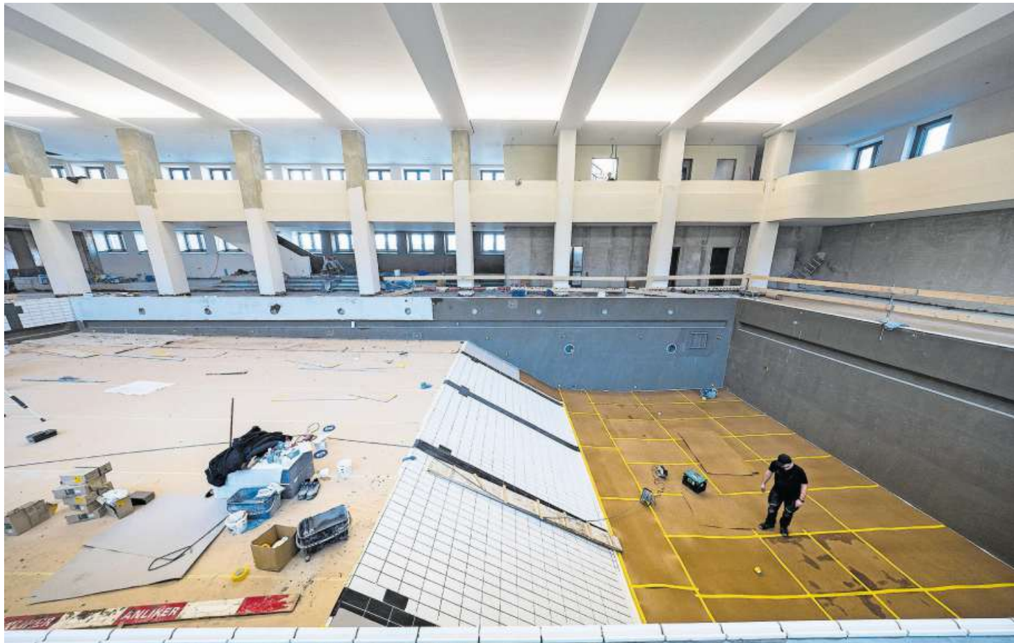
Das sanierte Hauptbecken wird fertiggestellt. Die Farben sind frischer, schlichter und moderner.
