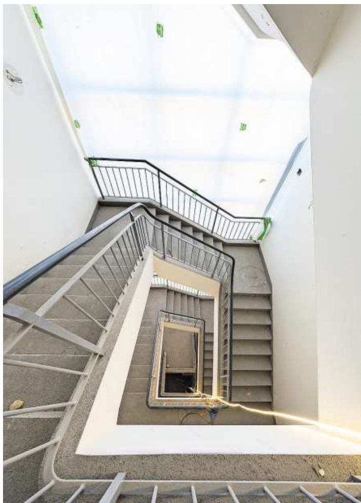
Auch die Wohn- und Geschäftsbereiche sind jetzt durchgängig und zeitgemäss erschlossen. Zudem wurden neue Lifte eingebaut.
