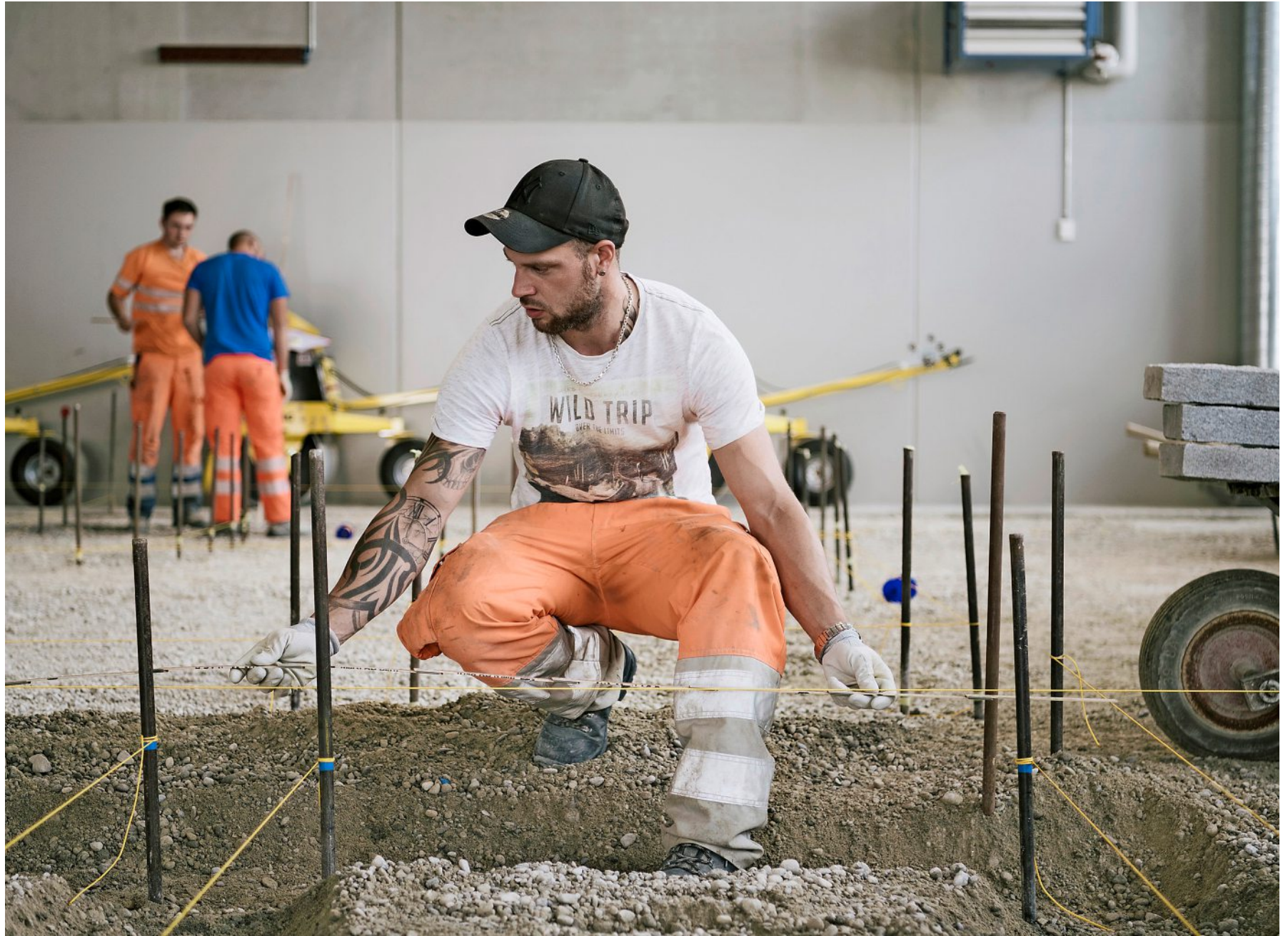
Alain Steinmann macht eine Lehre als Strassenbauer. «Ich war auch schon auf Baustellen, wo wir gewusst haben, dass die Zeit nie reicht», sagt er. Foto: Samuel Schälch
