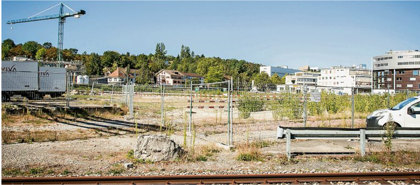
Die Christoph-Merian-Stiftung will das Land anderweitig genutzt wissen: Das ehemalige Areal der Debrunner Acifer AG. Foto: Nicole Pont
