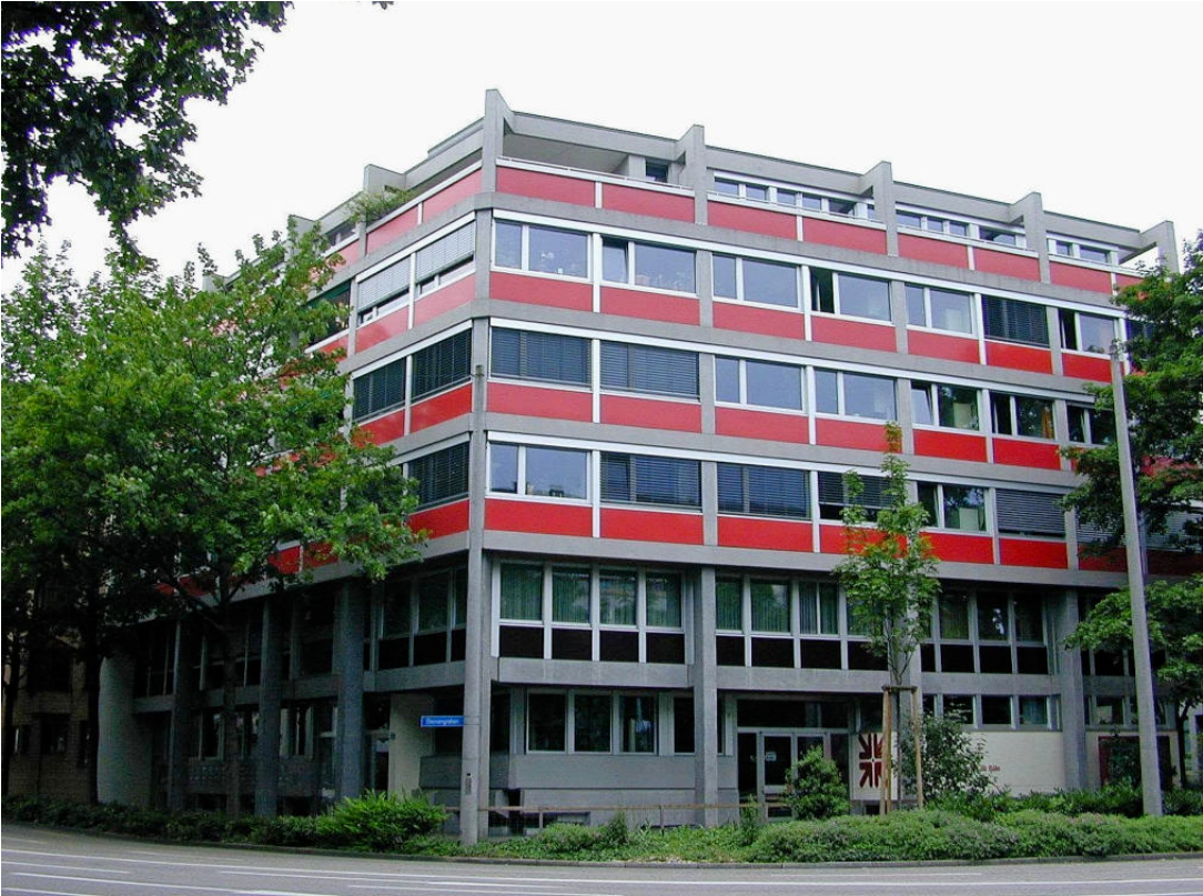
Das auffälligste Gebäude am Holbeinplatz: Das «Centre» vor der Sanierung. Bild: zvg
