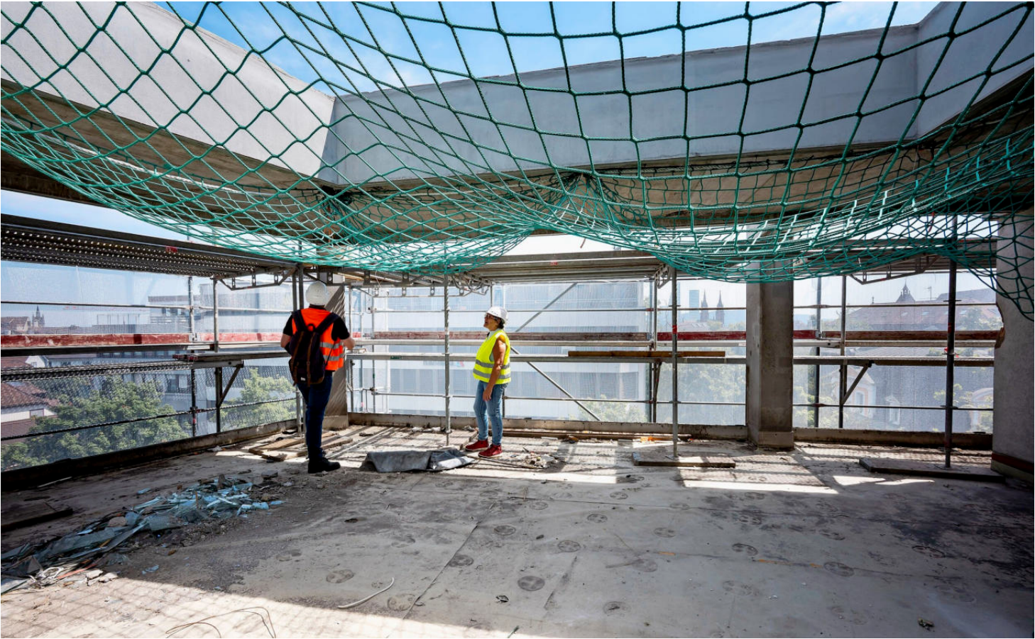
Nur noch ein Gerippe: Das «Centre» am Holbeinplatz wurde bis auf die Tragstruktur abgetragen. Blick vom 5. Stock. Bild: Kenneth Nars
