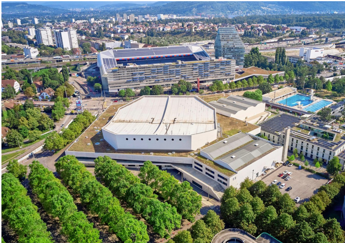
Die drei Dächer der St. Jakobshalle werden zum kantonalen Solarkraftwerk aufgerüstet.
