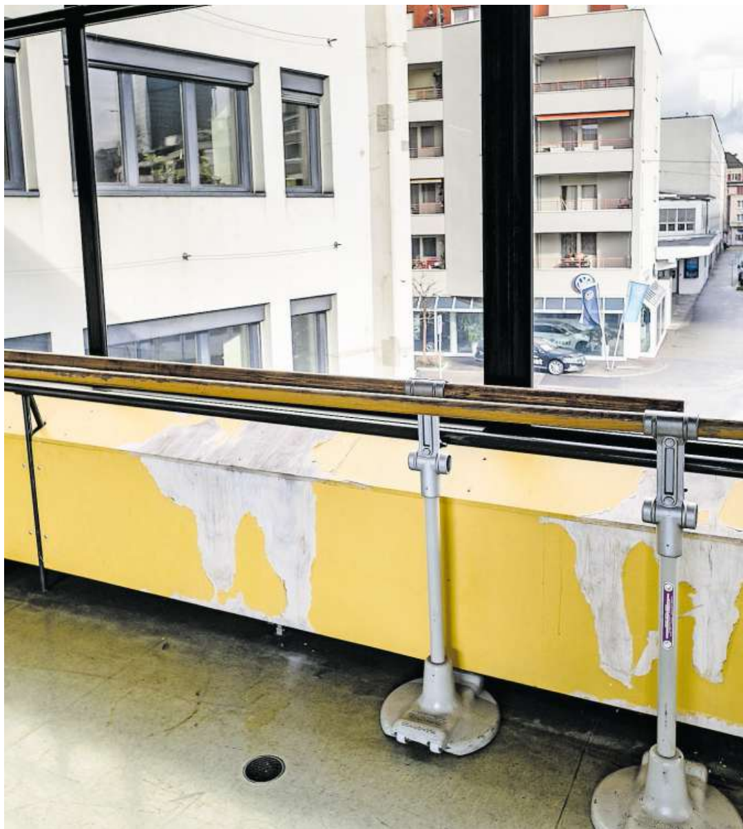
Hoher Sanierungsbedarf: das Musical-Theater Basel.
